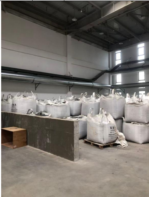
全封闭堆场，洒水喷淋
