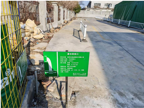
污水排放口 DW001
