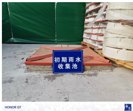
初期雨水收集池
