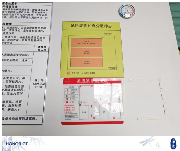
危废仓库（次生危废库）分区标志
