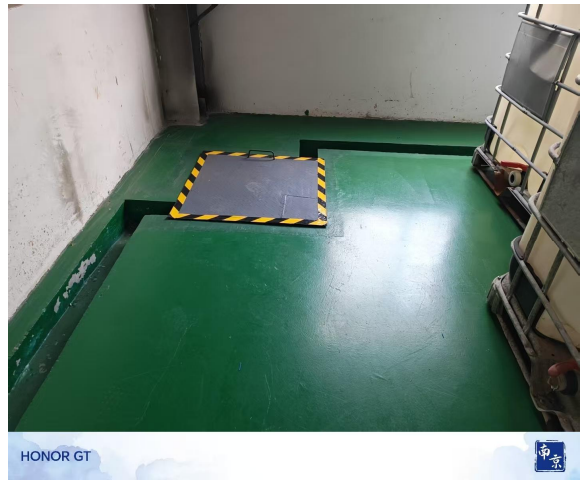
危废仓库（次生危废库）集液槽
