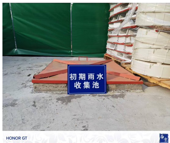
初期雨水收集池
