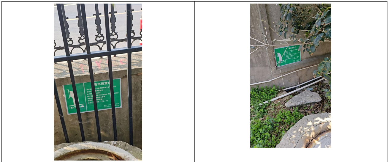
雨水排口及标识牌
