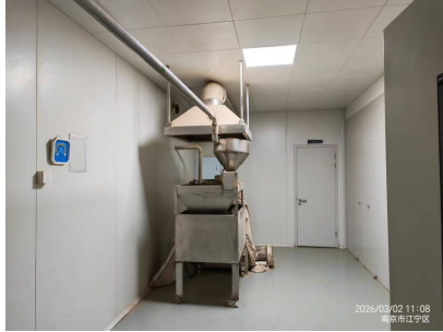
风选废气收集集气罩
