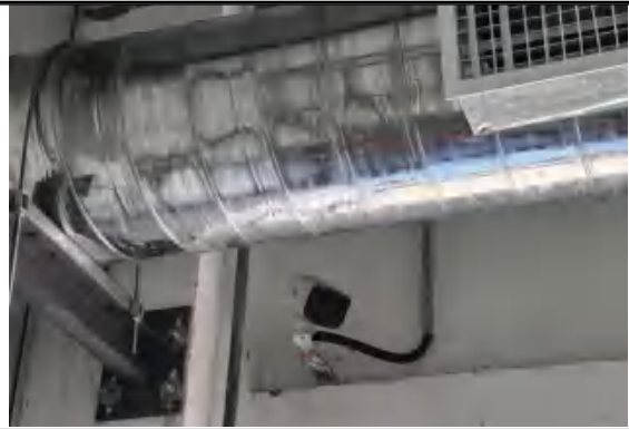
危废仓库监控
