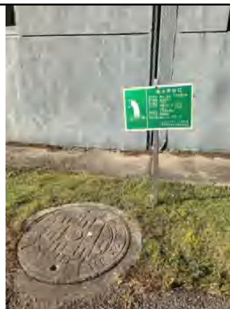
雨水排放口标志牌
