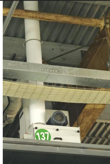
清洗废气油雾净化器 (TA052)
