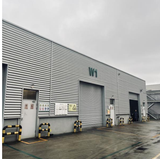
危废贮存设施及环保标志牌
