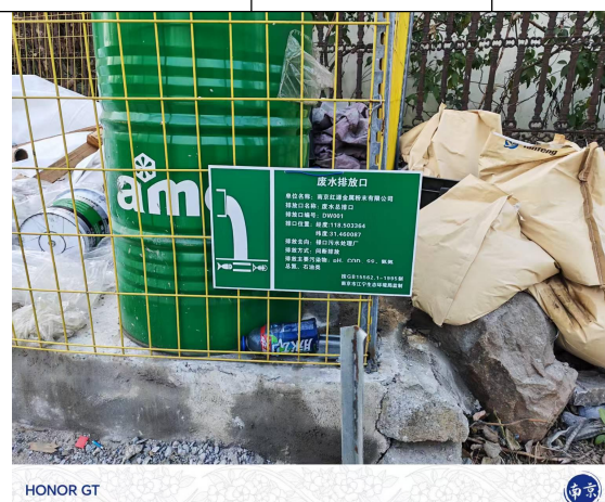
污水排放口 DW001
