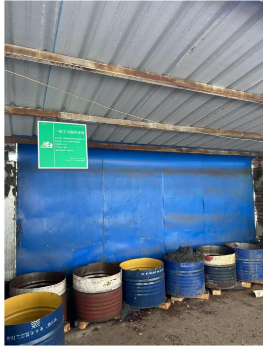
一般工业固废仓库
