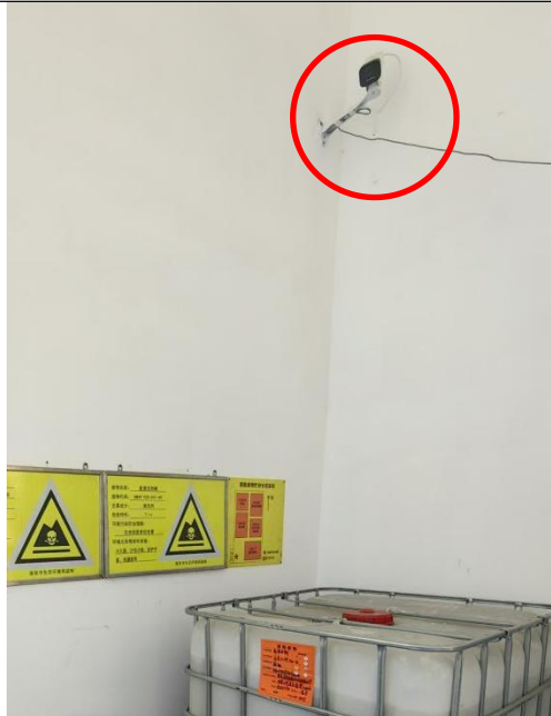
危废库内部监控
