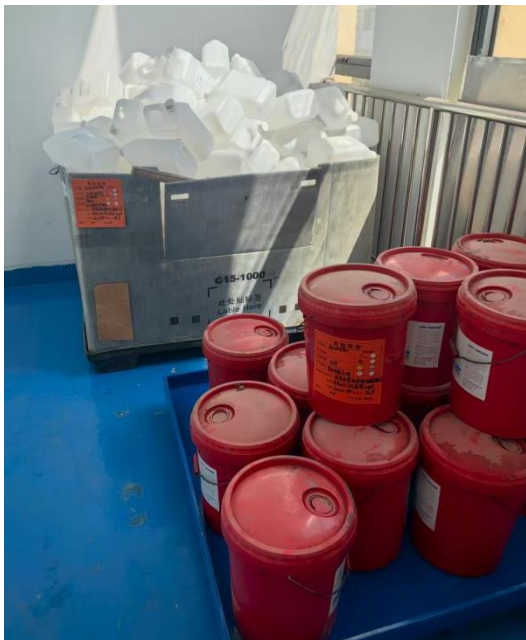
危废库防渗地面
