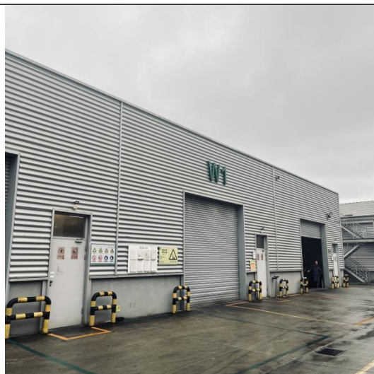
危废贮存设施及环保标志牌
