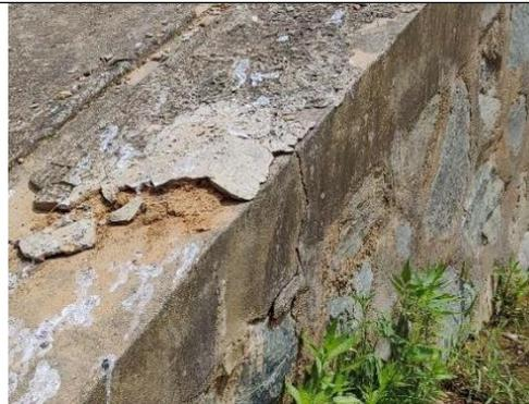
进口段左侧边墙压顶破损
