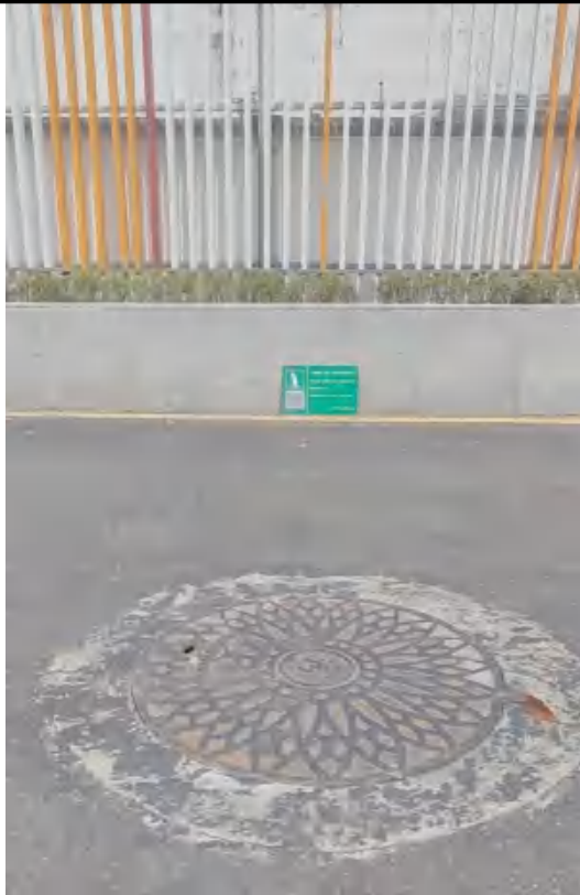
污水排放口标志牌
